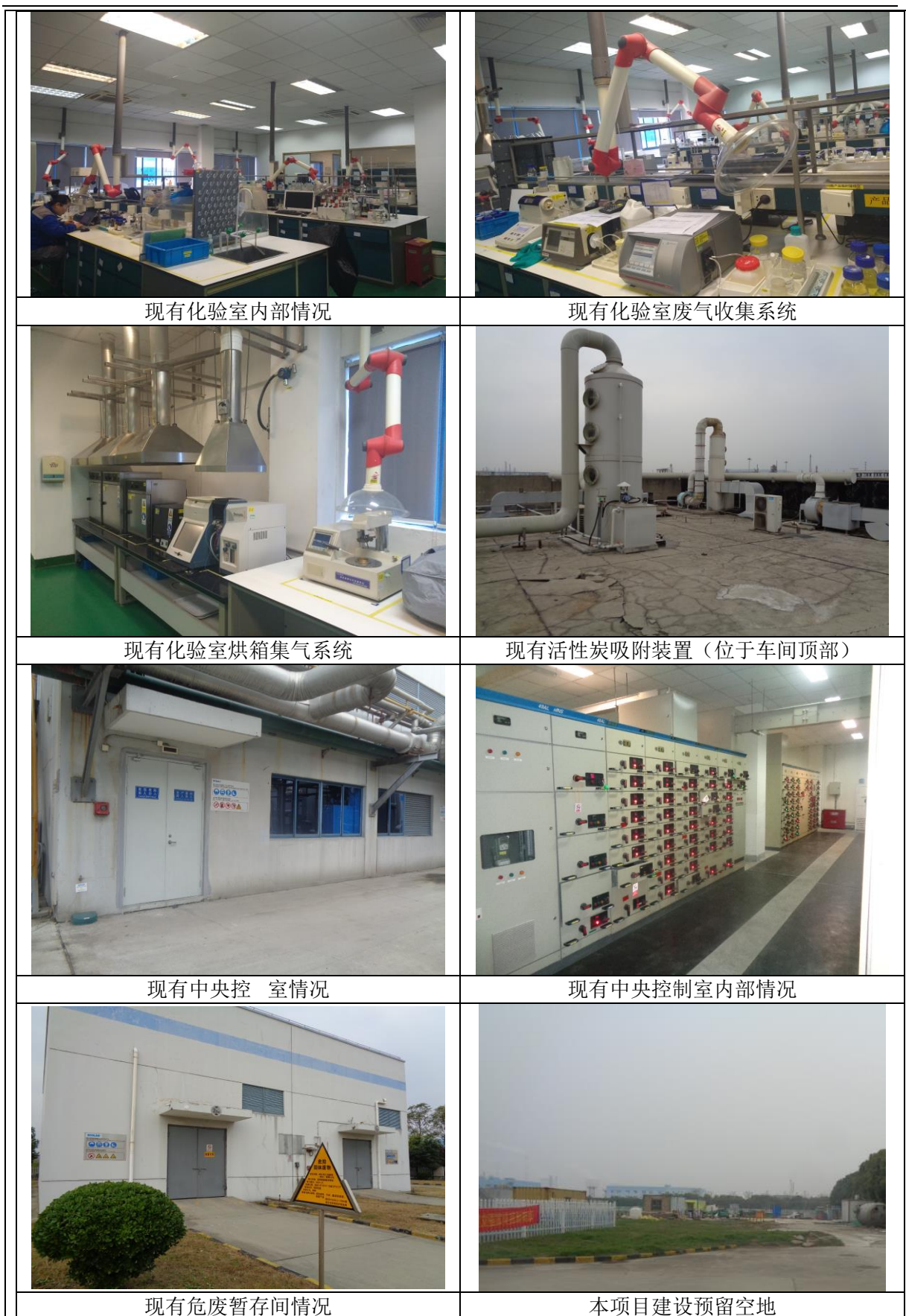
图 1-1 现有项目建设情况图
