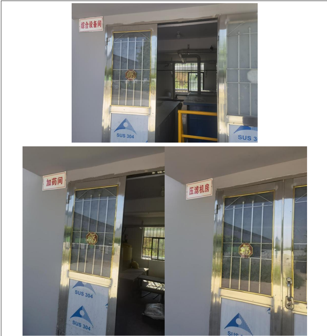
图 3-3 研发中心三期污水处理站设施
